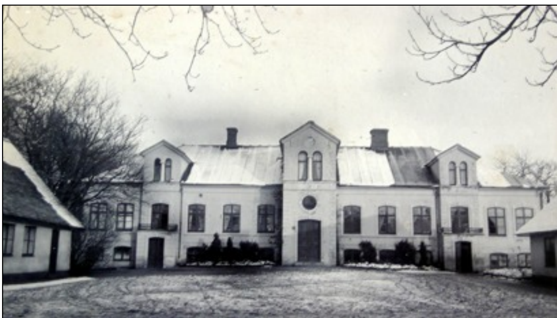
Efter femtio år behövde Svedin Karströms corps de logis rustas upp och Peter Kockum lät 1870 genomföra en modernisering och ombyggnad som gav byggnaden dess nuvarande utseende.
