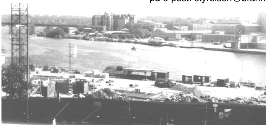
Våren 1980, tidiga husgrunder en början på brf. Bränneriet
