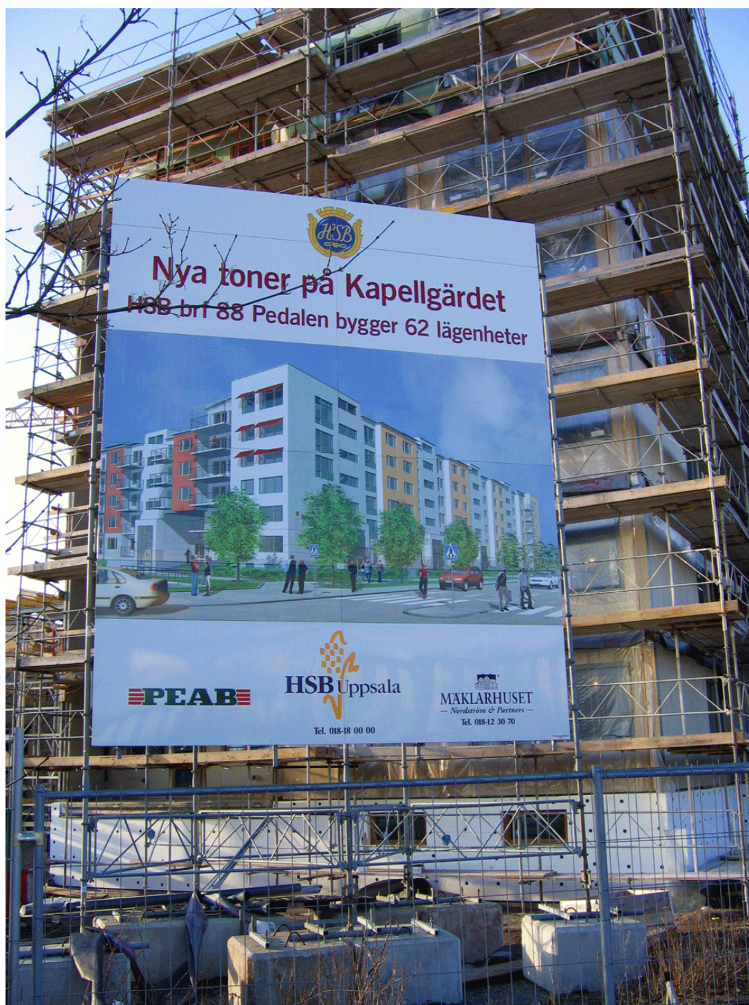
Byggandet av Portalen april 2006
